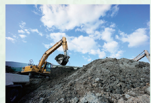
CONSTRUCTION SLUDGE 建設汚泥処理
